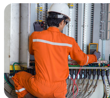
Elektro- und Gerätetechniker bei der Fehlerbehebung an einer programmierbaren Steuerung eines Öl- und Gasförderungssystems, Arbeiter auf einer Offshore-Ölplattform.
